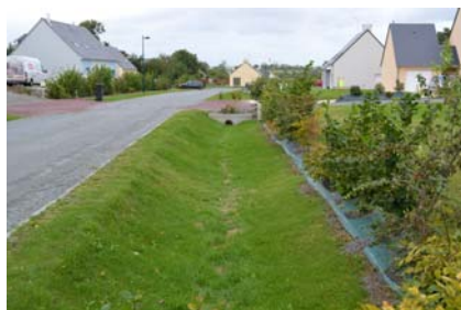
Noues en herbe à la place d'un bassin de rétention
